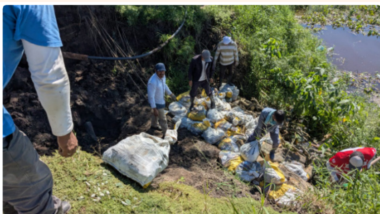
崩れた土手に土嚢を敷き詰めて応急処置。4月29日
