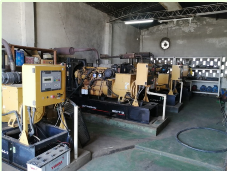
レダのジェネレータ（発電機）：奥からⅠ、Ⅱ、Ⅲ、Ⅳと番号が振ってあります。現在、構内で使用できるのはⅠ、Ⅲの2台のみです。Ⅰの最大出力は150kVA、Ⅲの最大出力は110kVAです。
