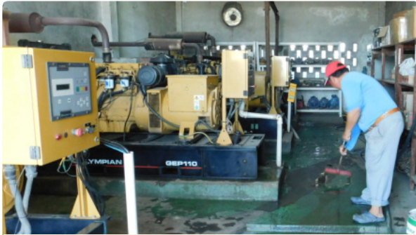
レダの自家発電設備：定格出力44kVA~150kVA
