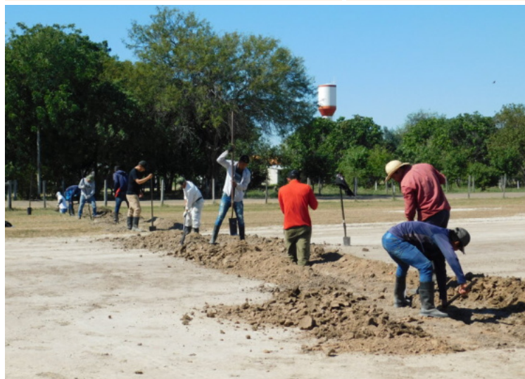
光ファイバーケーブルを埋設するための準備工事。8月5日
