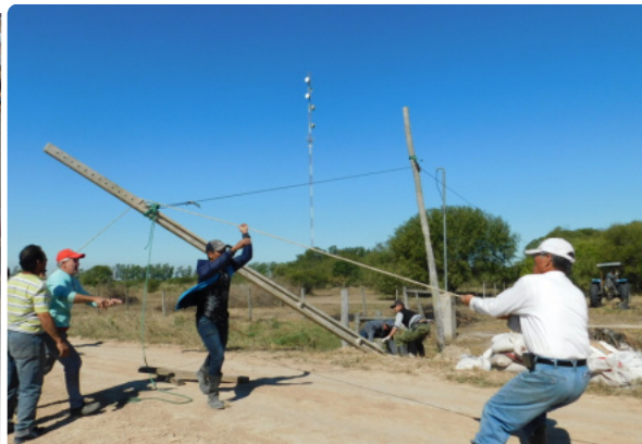
光ファイバーケーブルの電柱を立てる作業。
