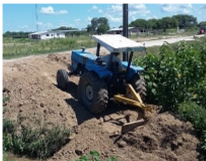
排水溝を塞ぎ排水管を埋める。
