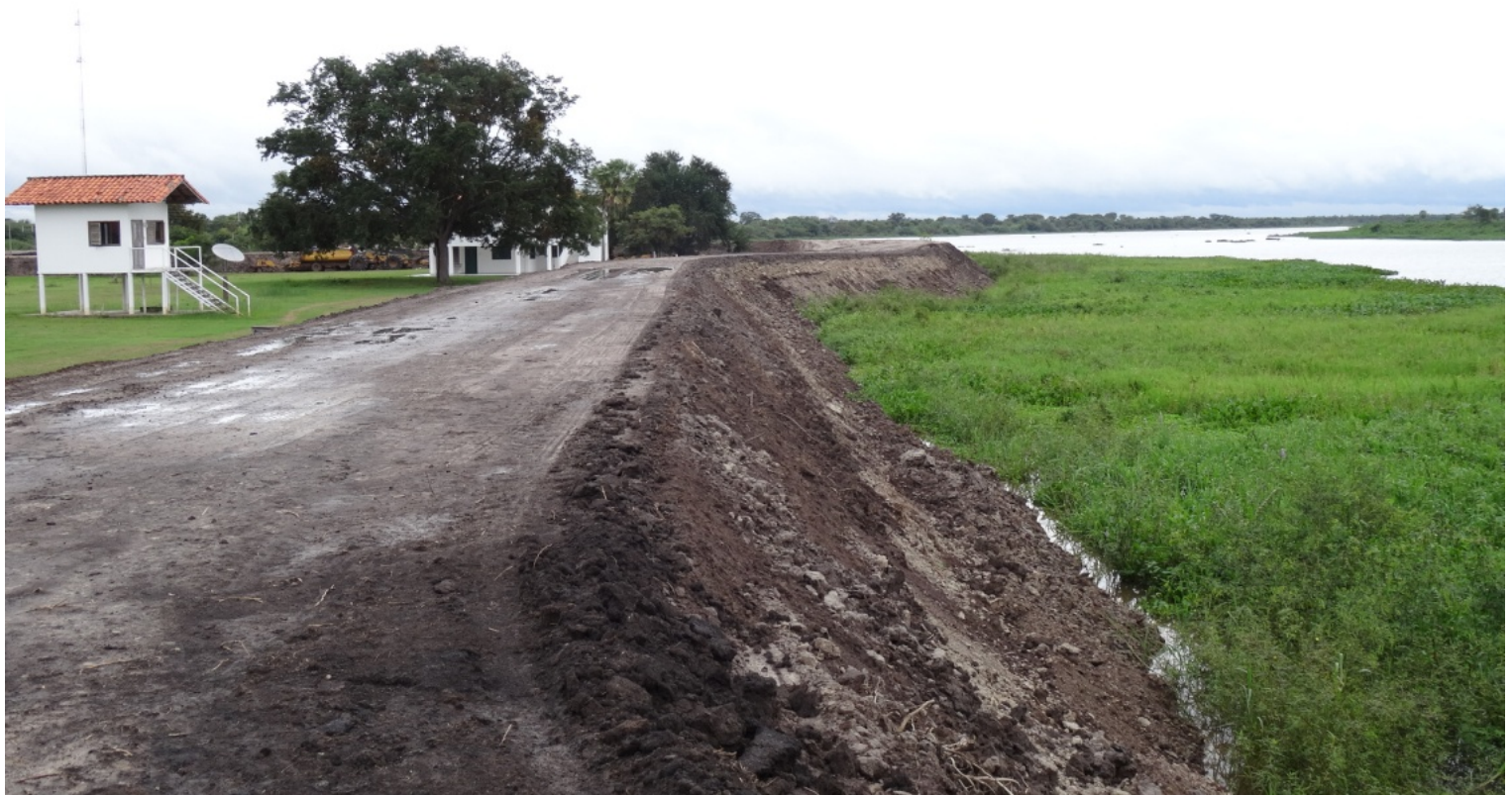
堤防建設工事は、ここゲストハウス前から始まった。従来よりも2m高くなって、水位上昇による浸水を防ぐ。(5月31日撮影)
