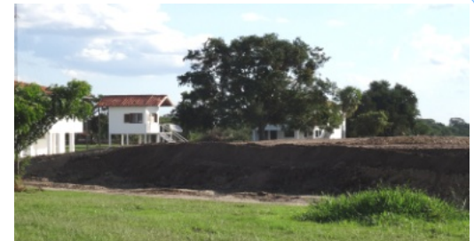
高さ2mに積み上げた堤防（旧館付近）
