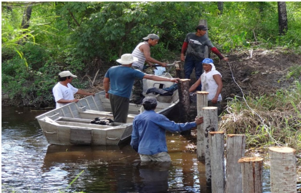
硬い木の杭を打ち、ワイヤーを張る作業員たち。先住民でなければ耐えられない。
