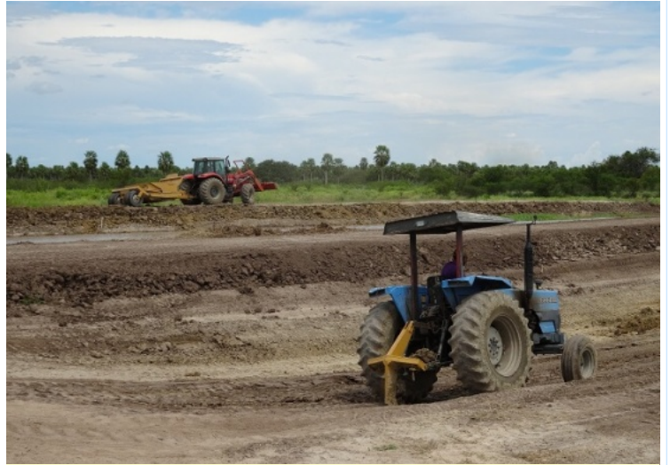
固い土を切る青いトラクターと、土を削り取る赤いトラクター
