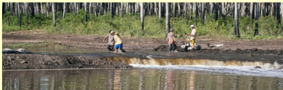
上山チームが決壊した堤防を緊急修理
